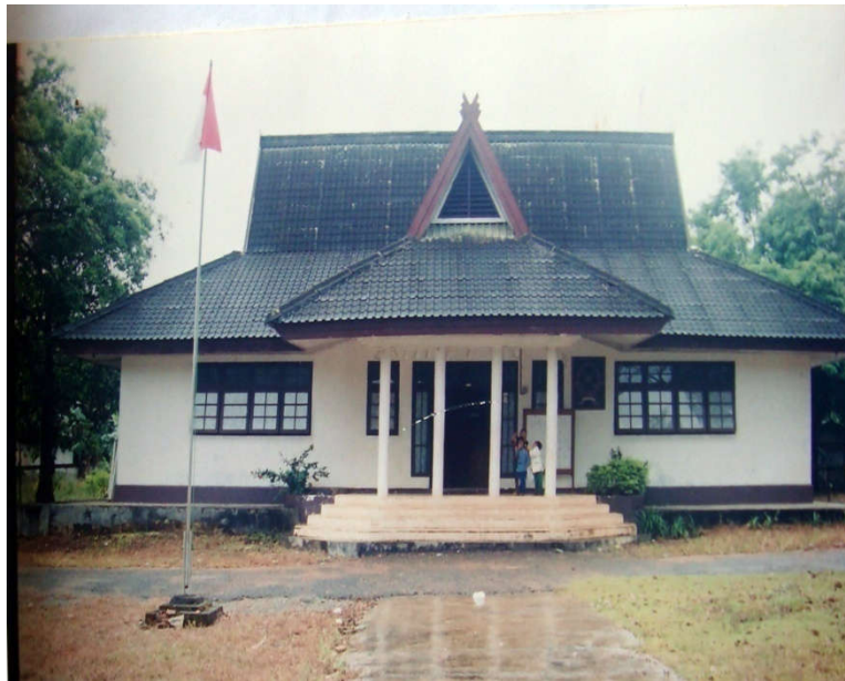
Gambar Gedung Balai Sidang Pengadilan Agama Pelaihari
