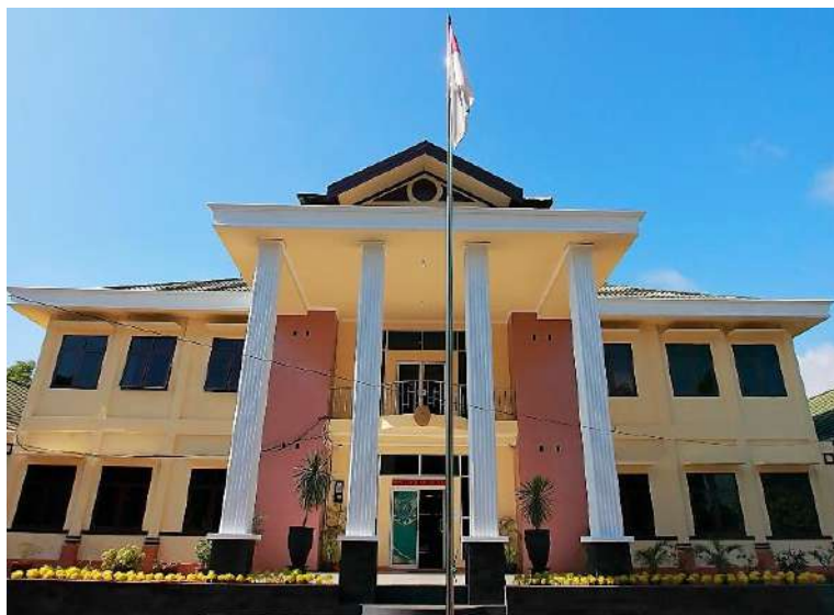
Gambar 1. Gedung Pengadilan Agama Pelaihari
